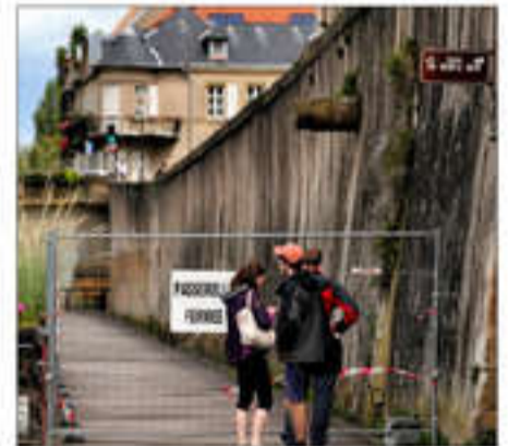
Il n'est plus possible de passer, le grilla est scellé.
